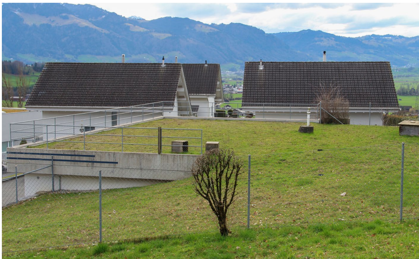
Dach der Betriebswarte
